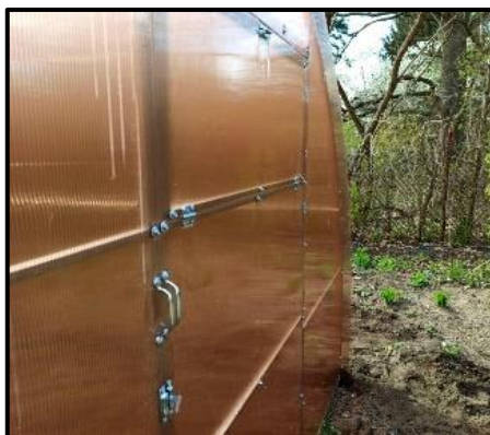
Obrázek č. 5 Rozmístění úchytek, pantů a háčků na konci rámu
